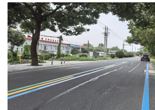
楼大线马沈站点现状东侧公交站
