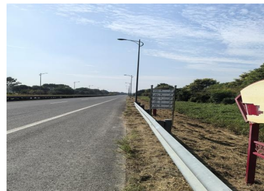
楼王线周花站点现状西侧公交站
