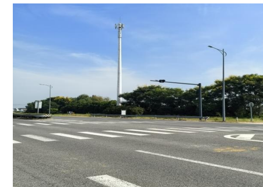
楼王线周花站点现状东侧公交站
