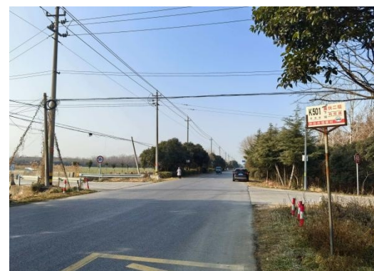
斗沙线董伙二组站点现状北侧公交站
